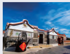
二炭傳統聚落保存区
