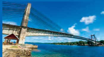
日本・パラオ友好の橋(パラオ)
