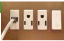
客室内コンセント(イメージ)
