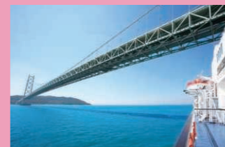
明石海峡大橋
