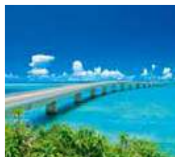
宮古島／伊良部大橋
