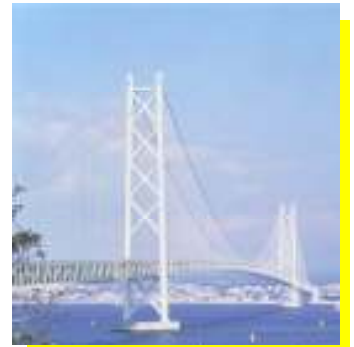
明石海峡大橋
